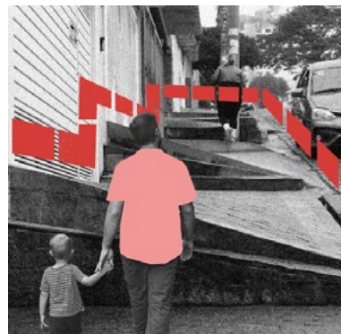
← Figura 22 As rampas e degraus executados na calçada estão em desconformidade com as normas construtivas, dificultando a caminhada de qualquer indivíduo e tornando a caminhada com crianças mais novas um desafio. Cuidadores com carrinhos de bebê ou cadeirantes precisam utilizar o leito das vias para se deslocar nessas situações, colocando-se em perigo.
